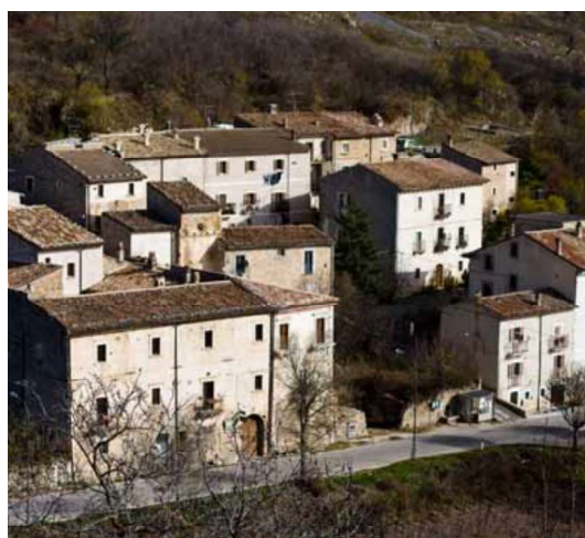
КРЫШИ ДОМОВ У СТЕНЫ БОРГО САНТО-СТЕФАНО
